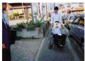
歩道が車道方向に傾斜している
