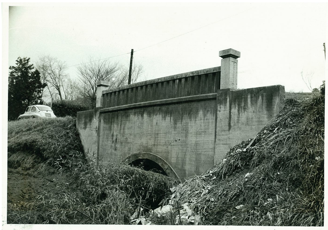
『逆川橋 大正 13 年架設』
