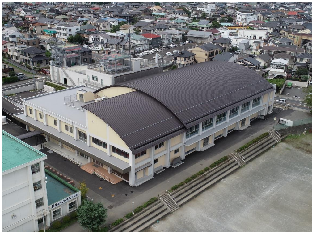
西中学校多機能型体育館
