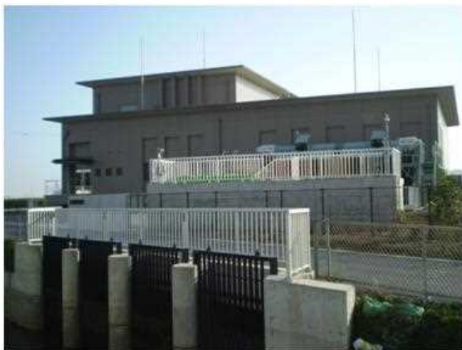
大根川ポンプ場 (平成 24 年 11 月供用開始)
