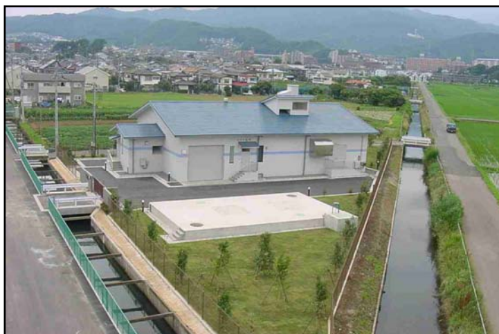
鶴巻中継ポンプ場 (平成13年7月供用開始)
