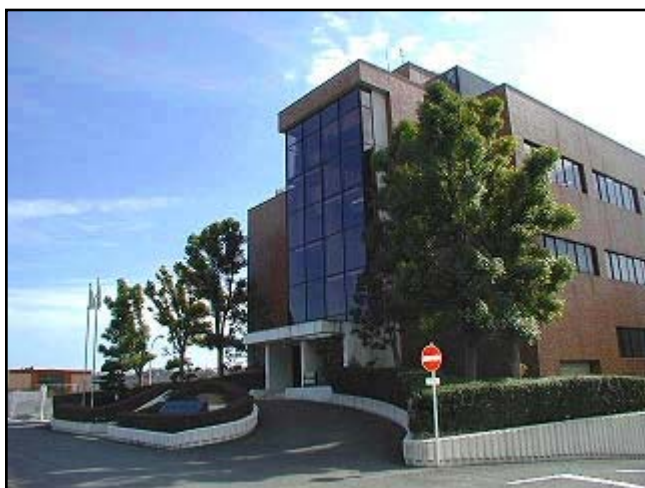
秦野市浄水管理センター (昭和 56 年 2 月供用開始)
