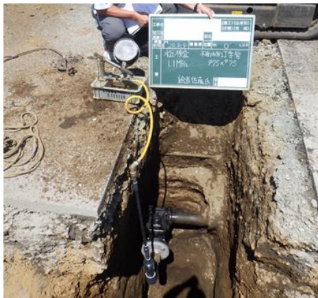
不断水割 T 字耐压試験
