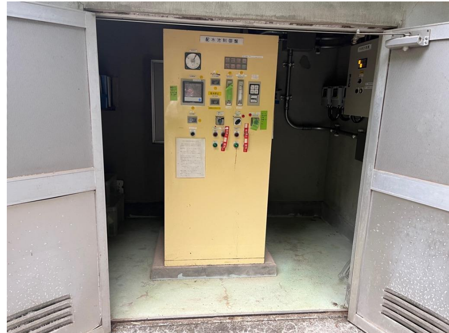
電気設備（監視盤）の更新
