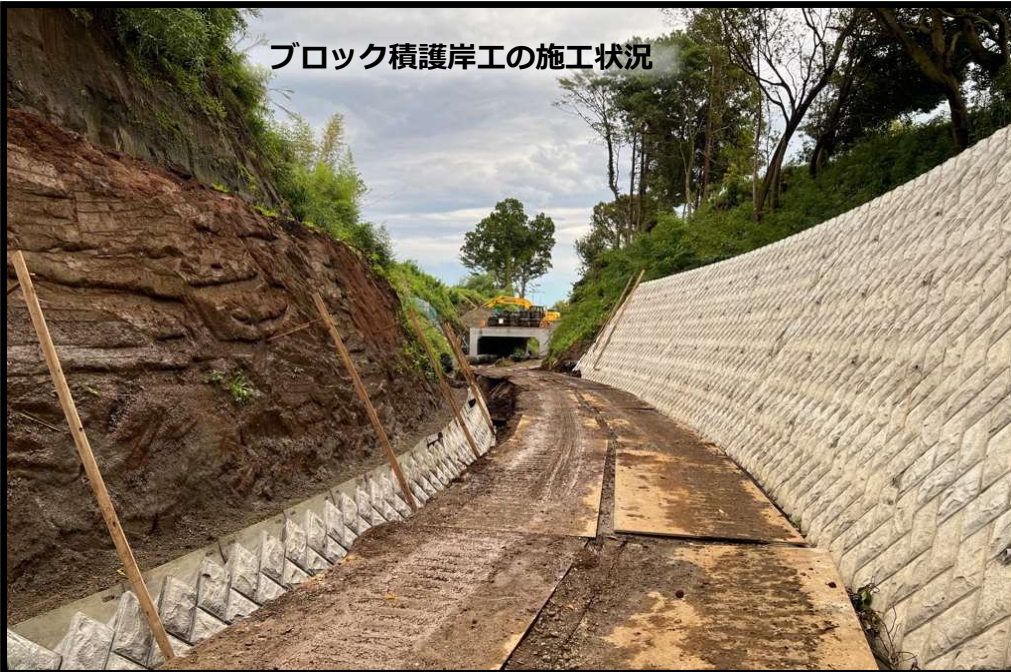
補強土擁壁の基礎施工状況
