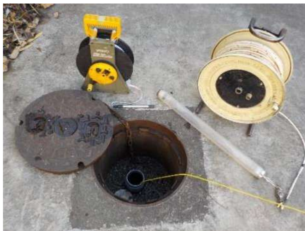
図 4-16 監視基準井戸 （井戸、水位計、採水器）
