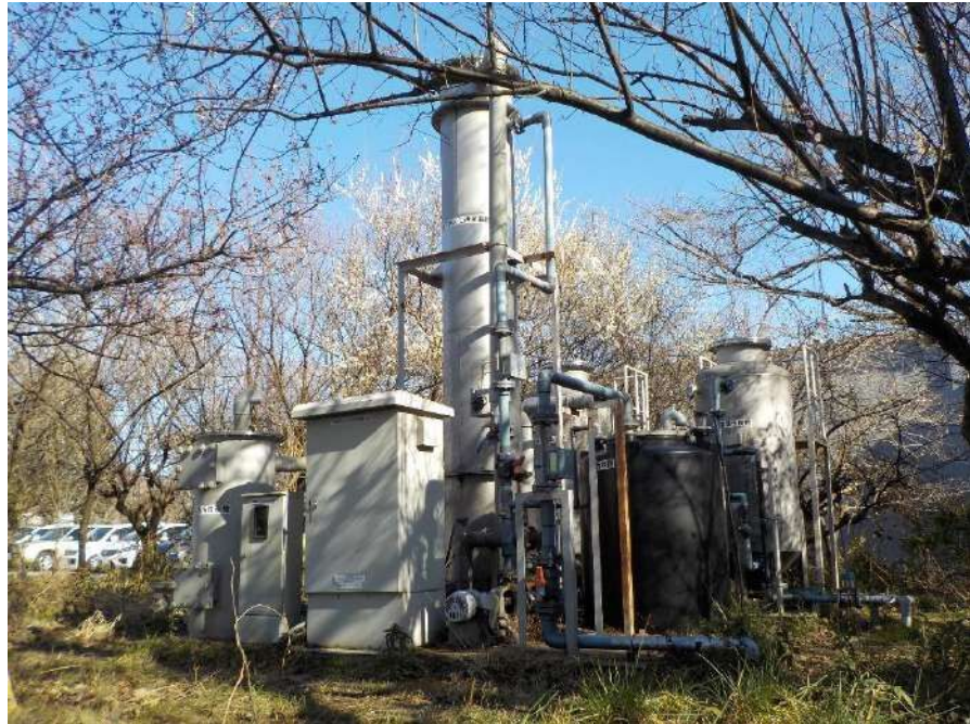
図 4-17 地下水浄化装置
