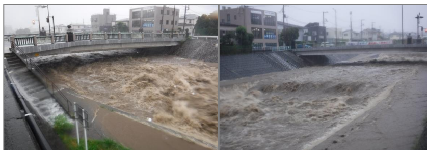
桜橋付近 ＜令和3年7月3日の豪雨時の桜橋付近の様子＞
