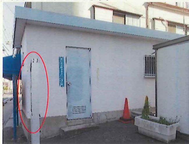
大気汚染常時監視測定局外観
