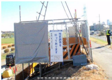
仮囲い設置例
