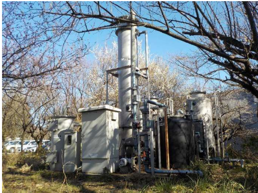
図 4-17 地下水浄化装置
