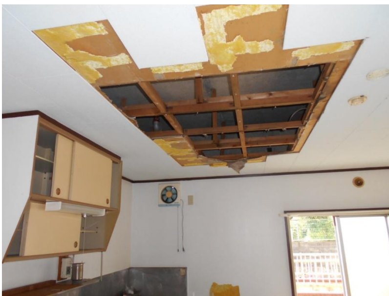
102 号室（車いす用住戸）天井板材崩落
