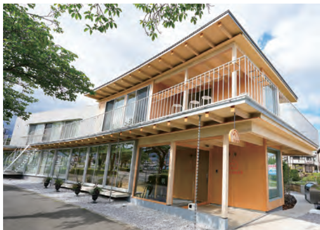
秦野産木材をふんだんに使用した外観。道路に沿って設計されているため街の景観になじむ
