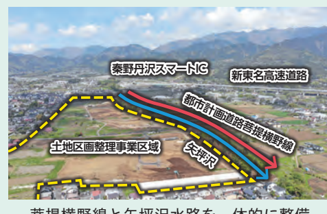
菩提横野線と矢坪沢水路を一体的に整備
