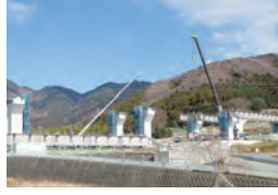
羽根トンネル付近
