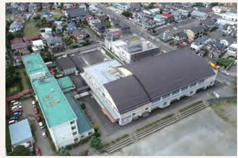
昨年8月に完成した西中学校複合施設
