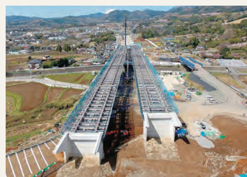
着々と進む新東名高速道路の工事(葛葉川橋)
