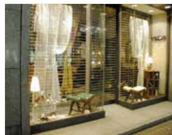
シャッターを内部に組み込み、閉店後もショーウィンドウを照らして見せている例
