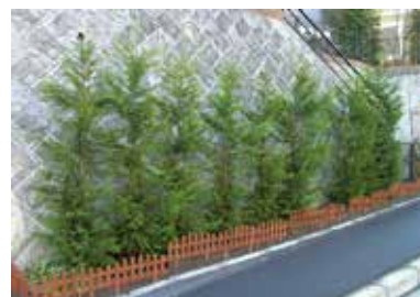
擁壁の足下を緑化している。
