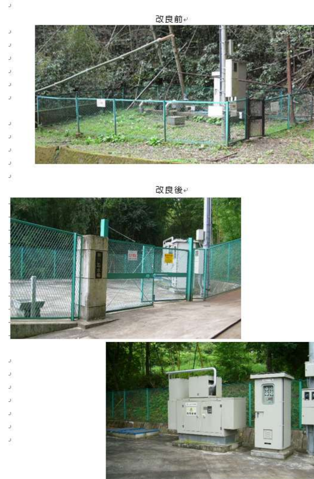
図表 2-2 柳川取水場の改良(深井戸化)
