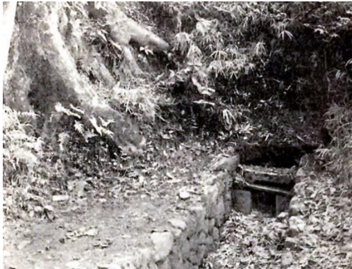
曾屋水道創設前から湧出していた水源（イ号水源）
