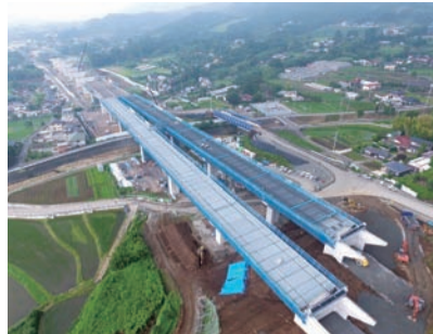
新東名高速道路建設工事の様子
