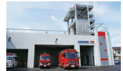
完成した消防署西分署
