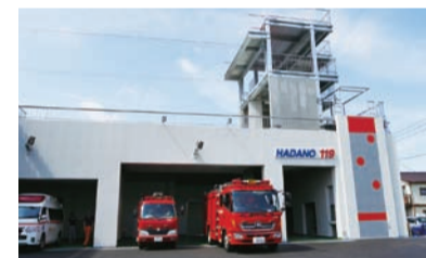
完成した消防署西分署
