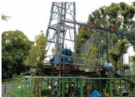
水理構造を把握し地下水マネジメントへの活用を (写真は地下水調査ボーリングの様子)
