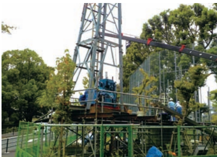
水理構造を把握し地下水マネジメントへの活用を（写真は地下水調査ボーリングの様子）
