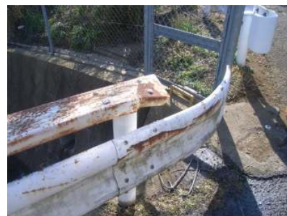
防護柵: 変形・欠損(対策区分 M)
