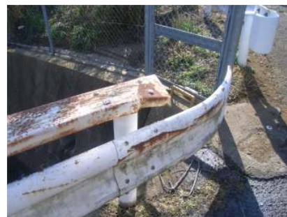
防護柵: 変形・欠損(対策区分 M)
