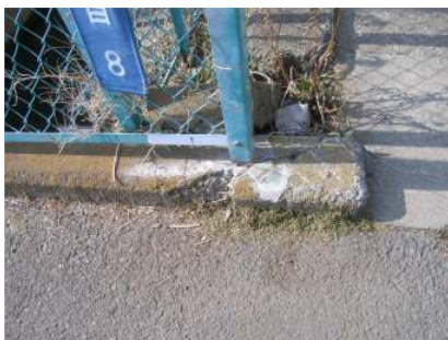
地覆: 変形・欠損(対策区分 M)
