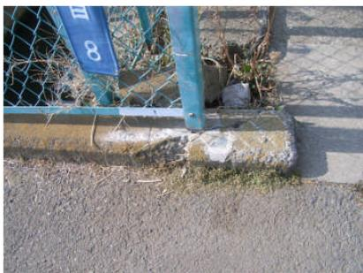
地覆: 変形・欠損(対策区分 M)
