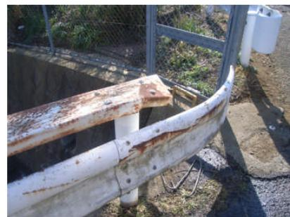
防護柵: 変形・欠損(対策区分 M)
