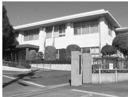
早期に管路の耐震化を (写真は水道庁舎)
