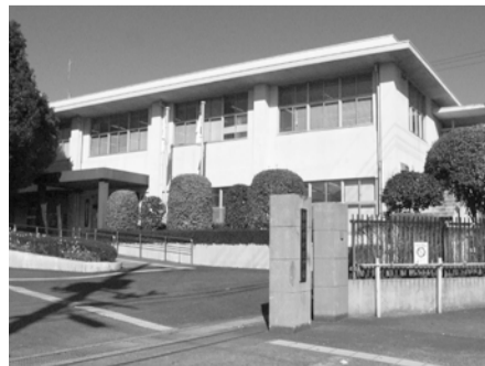
早期に管路の耐震化を(写真は水道庁舎)
