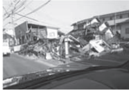
熊本地震で倒壊した家屋 (写真は熊本県益城町)
