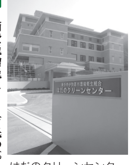
はだのクリーンセンター
