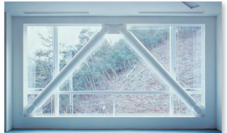
鉄骨ブレースのイメージ写真
