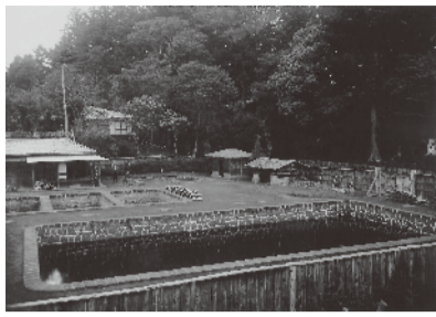
水道創設時の曾屋排水場
