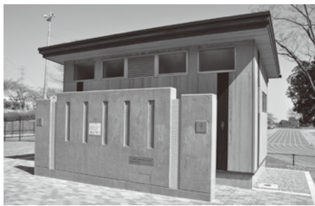
整備された陸上競技場のトイレ
