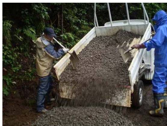
軽トラックで砂利を運び込みました。
