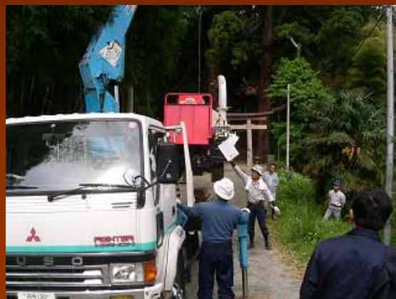
チップ機をクレーン車で搬入
