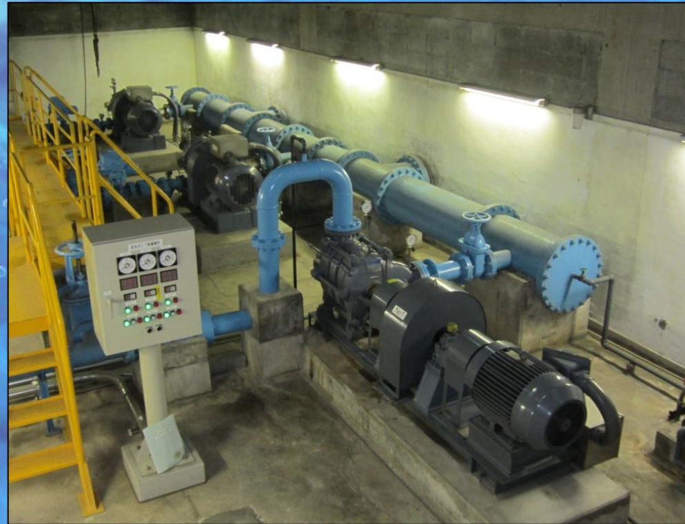
金井場配水場
