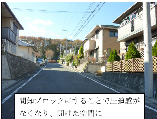
化粧型枠にて施工
