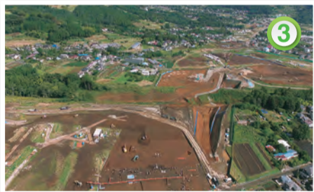
工事用道路の造成と埋蔵文化財調査
