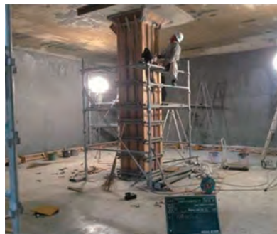
一部終了した広畑配水場の耐震補強工事
