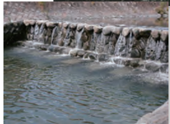
現在の水無川(秦野市役所付近)
