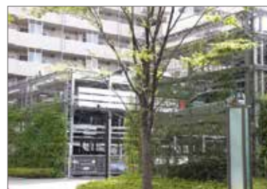
機械式駐車場の修景例。歩行者空間側に緑化フェンスを取り付け緑で覆っている
