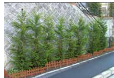
擁壁の足下を緑化している。
