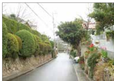
擁壁の間を植栽の空間としている
